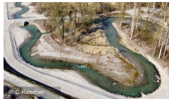
Eine sehr gute Lösung für die Nasenwanderung sind überfallsfreie Umgehungsgerinne mit ausgeprägten Prall- und Gleithangstrukturen. Voraussetzung auch hier: geeignete Wassertiefen und -breiten, die sich nur mit ausreichender Dotierung erzielen lassen.
