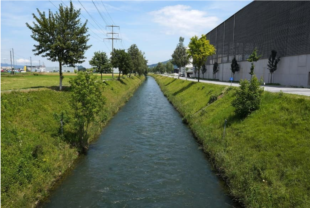
Abbildung 53: Charakteristischer, regulierter Abschnitt des Rheintal-Binnenkanals.
